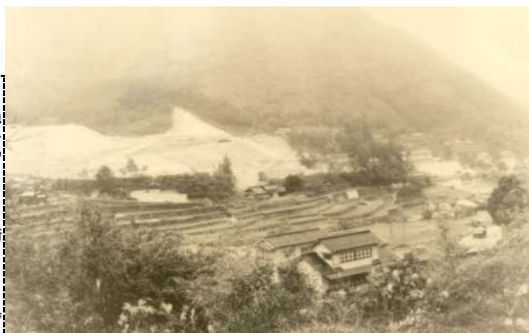
昭和49年11月、後山西望、あさひが丘団地造成中。右日浦小学校と谷筋に棚田が残る。〔ふるさと井口の歴史〕
